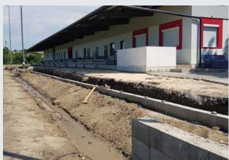
Neubau & Sanierung Kabinen und Tribünen Sportplatz Neudorf
