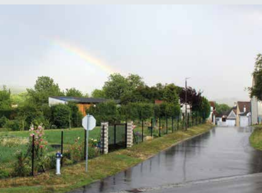
Sanierung „Dorfstraße“ Kirchstetten
