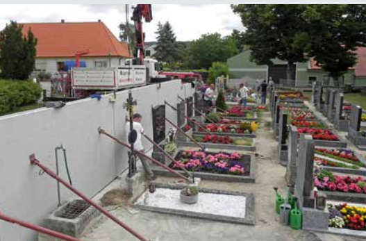
Neue Friedhofsmauer in Kirchstetten
