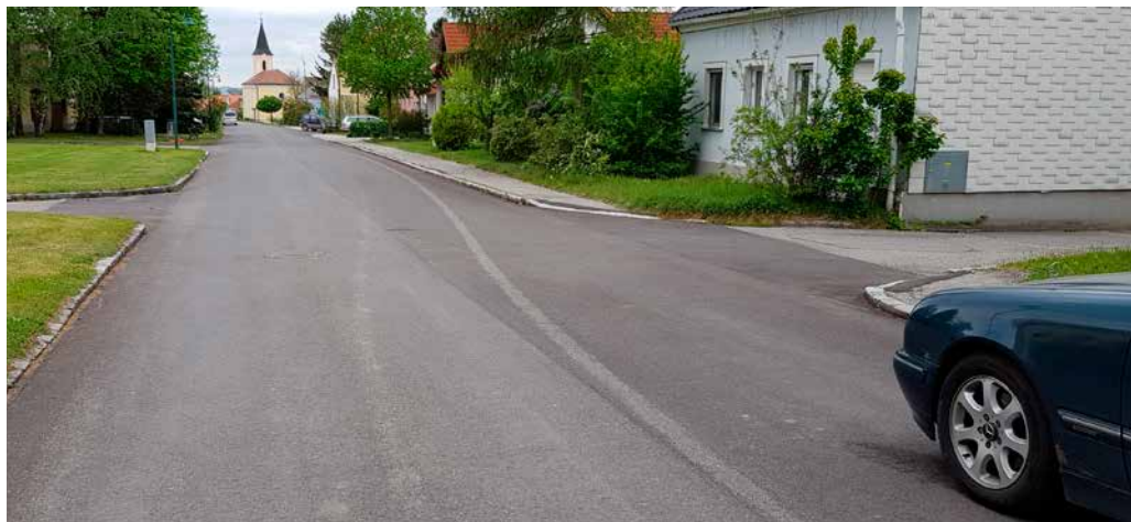
Belagsanierung „Kleine Zeile“ Zlabern
