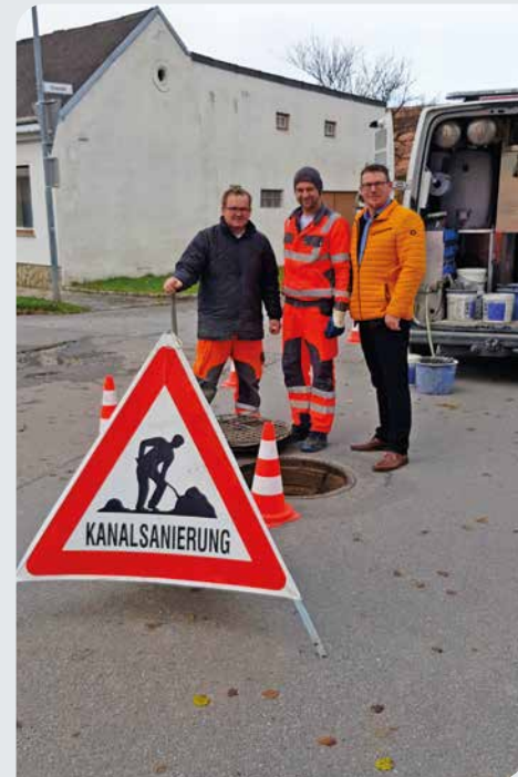
Start Generalsanierung L23 „Laaer-, Zlaberner Straße“
