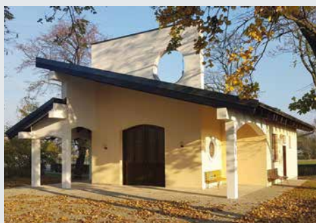
Sanierung der Aufbahnhalle
